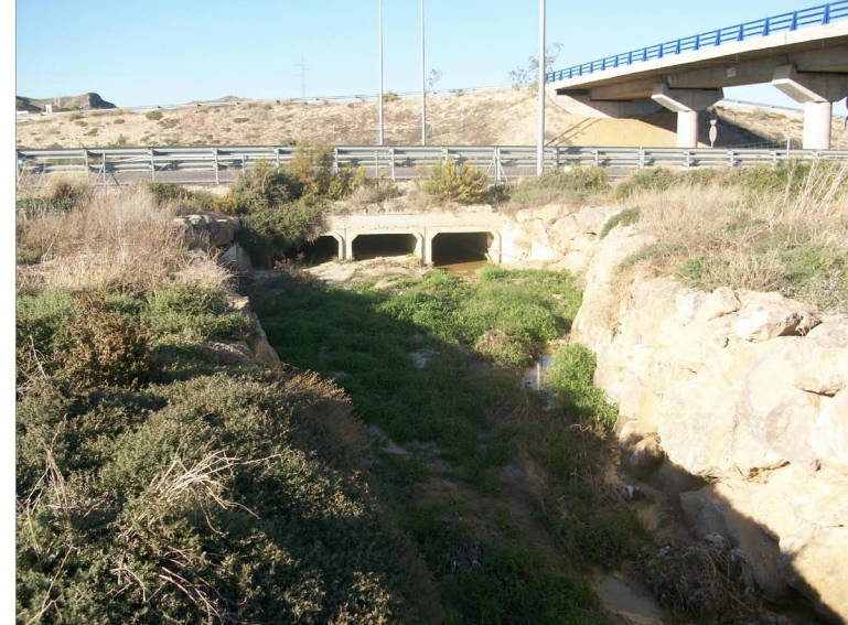
FOTO 2. Vista inicial del encauzamiento con los 3 marcos de hormigón al fondo
