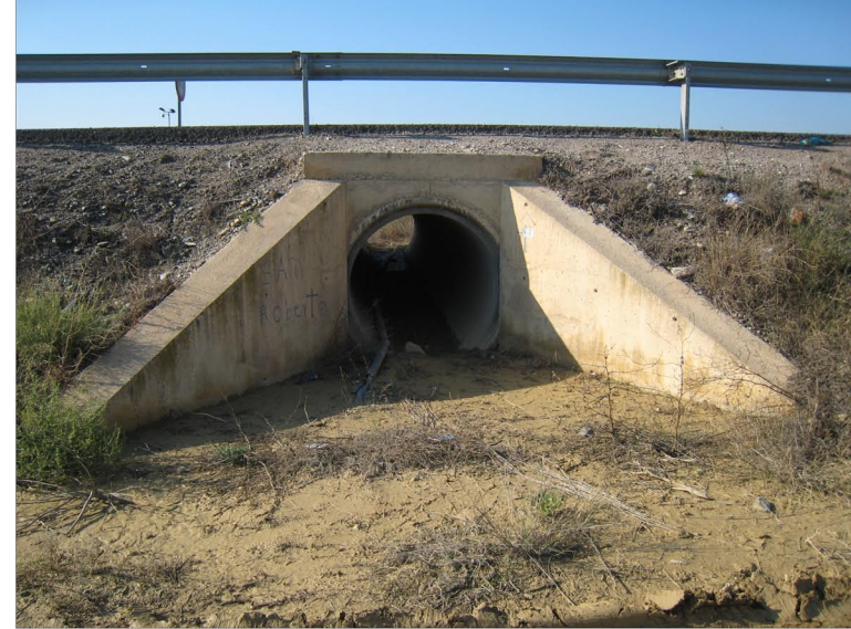
FOTO 5. Obra drenaje transversal Ø1.50m
