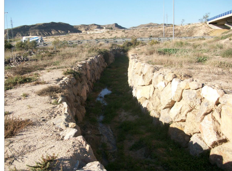
FOTO 3. Tramo con revestimiento de escollera.
