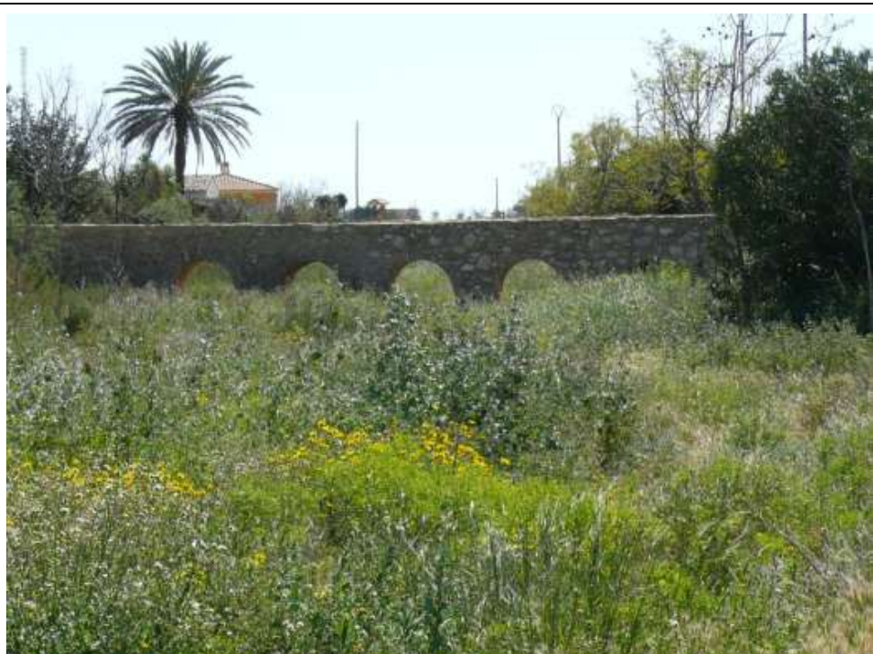
FOTO N°10: Vista de Rambla Albarrobo, con estructura en cauce. Vegetación existente
