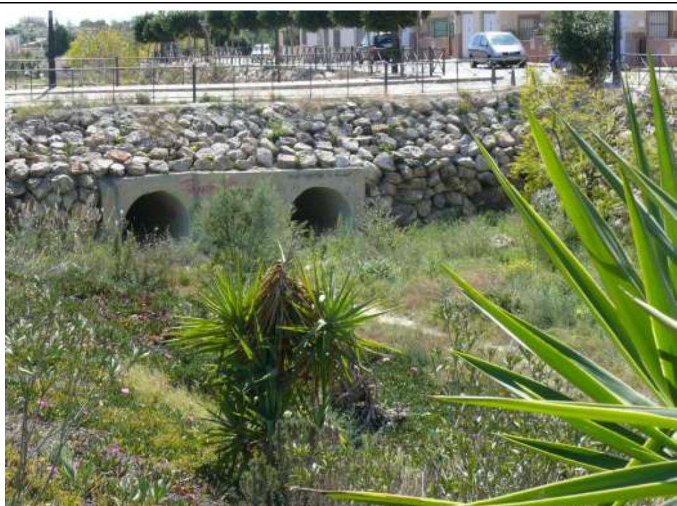
FOTO N°50: Obra de paso del vial sobre el cauce y vegetación taludes.
