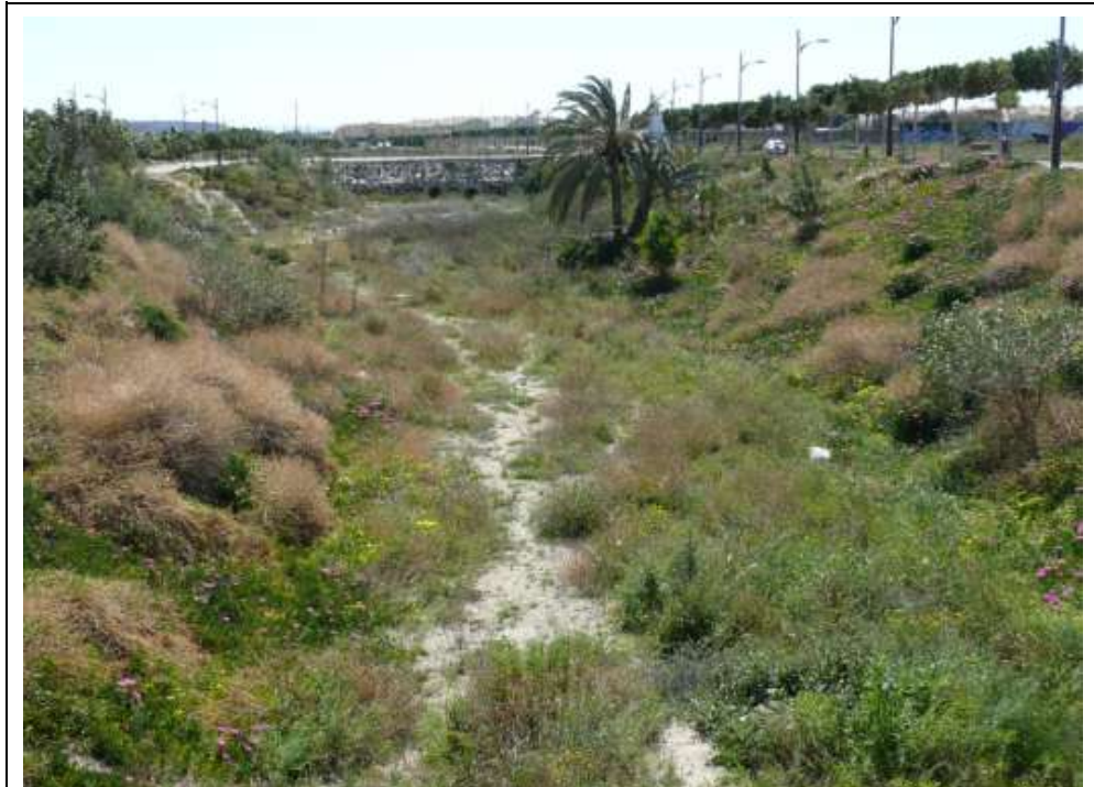
FOTO N°29: Vista Rambla hacia aguas abajo
