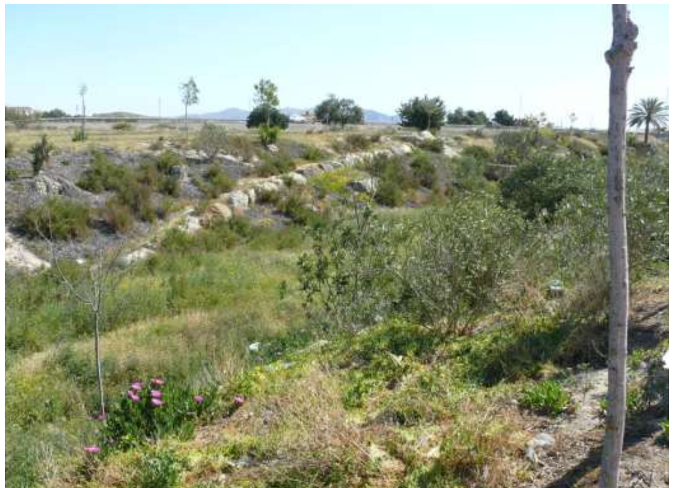
FOTO Nº11: Vista de Rambla del algarrobo en tierras hacia aguas abajo, taludes irregulares 3/2, vista rampa acceso.
