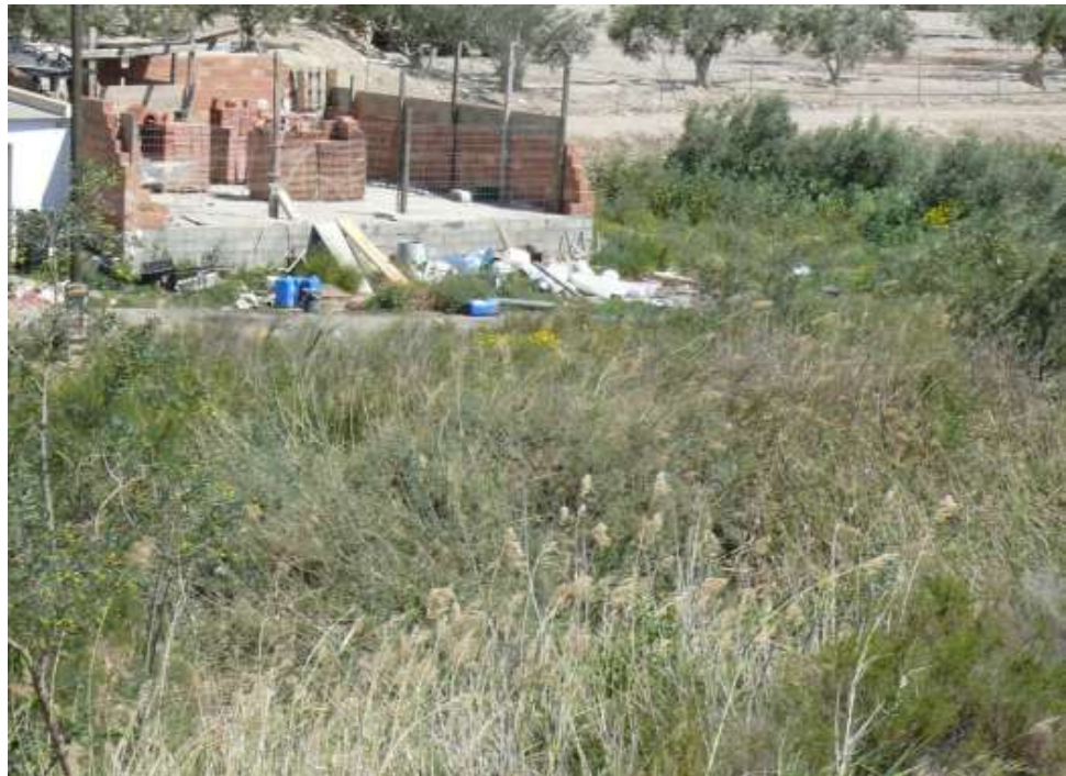
FOTO Nº69: Vista de edificación y camino paralelo al cauce en margen izquierda.
