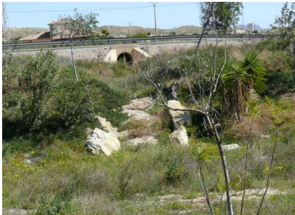
FOTO Nº25: Vista de obra de paso de Carretera hacia la Rambla del Algarrobo, taludes cauce 3/2 y 1/1
