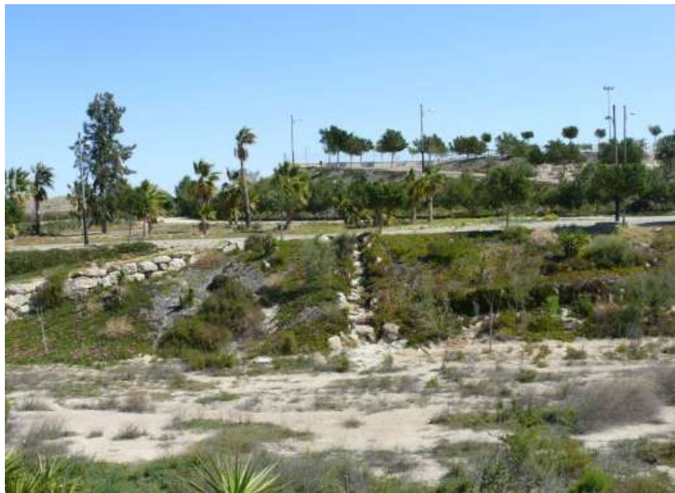
FOTO Nº33: Vista del margen izquierdo del cauce con rampa y bajante
