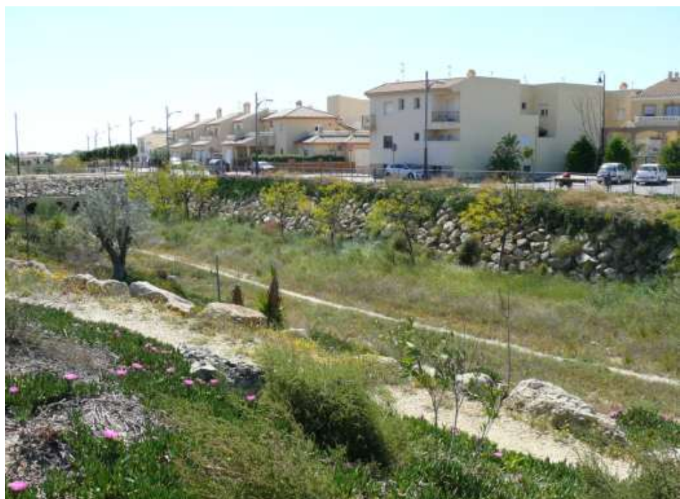
FOTO N°49: Talud del margen derecho del cauce en escollera en proximidad cruce vial sobre cauce
