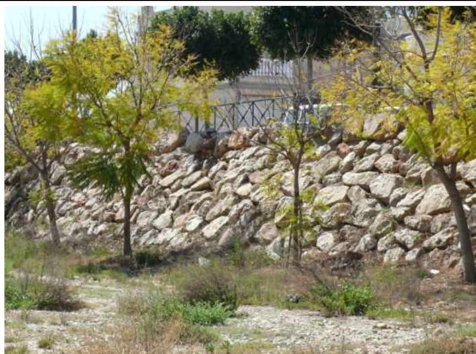
FOTO N°60: Vista de talud existente en margen derecha.
