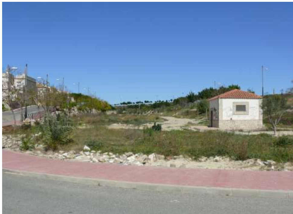
FOTO N°63: Vista de edificación existente en solera cauce y viario a cota solera cauce.
