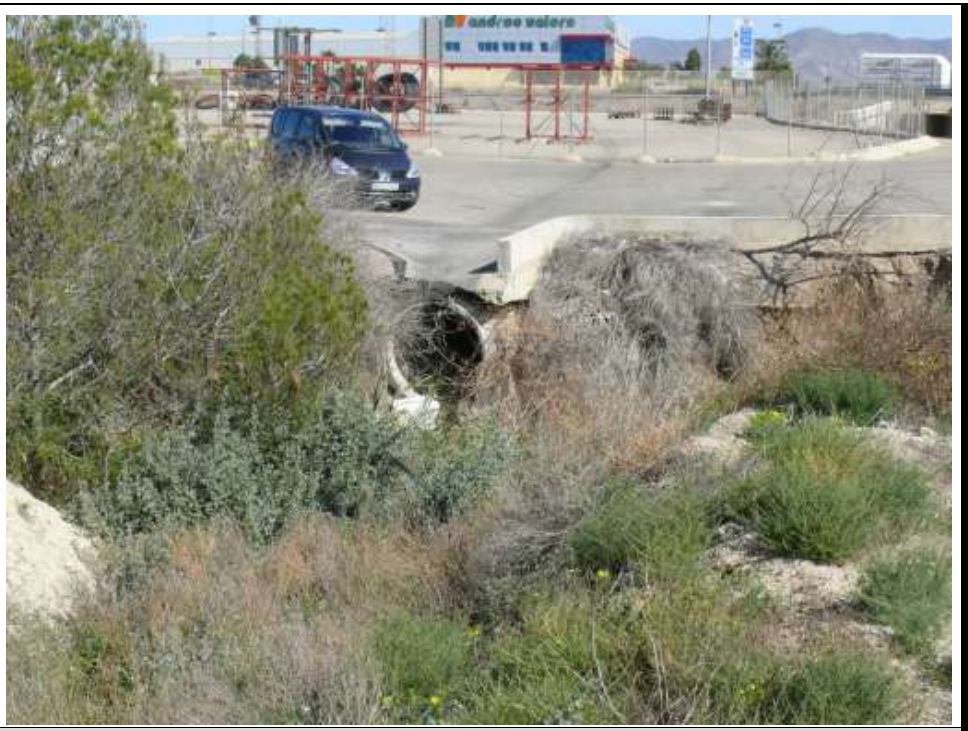
FOTO N°4: Vista de colector 1500 mm vierte a la Rambla del Algarrobo
