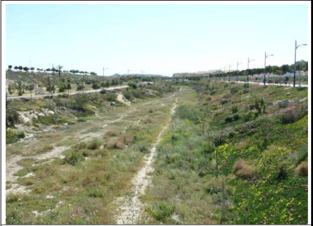
FOTO N°35: Vista de Rambla hacia aguas abajo desde estructura.
