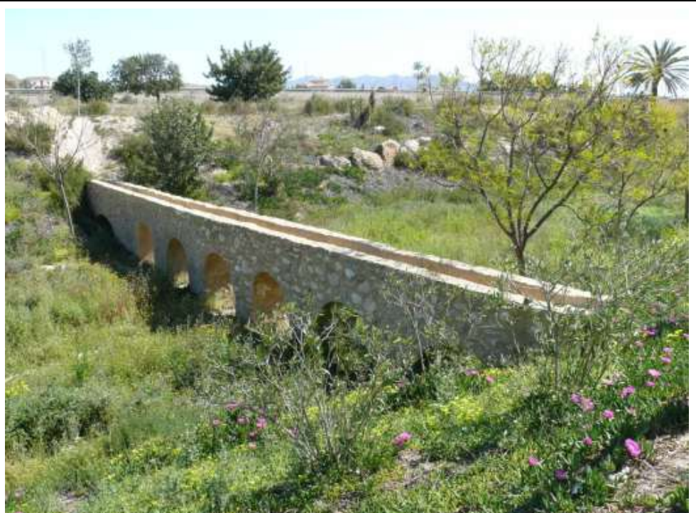
FOTO Nº12: Estructura en cauce con 7 pasos, 5 de los cuales tienen sección similar circular de 1500 mm y resto inferior.
