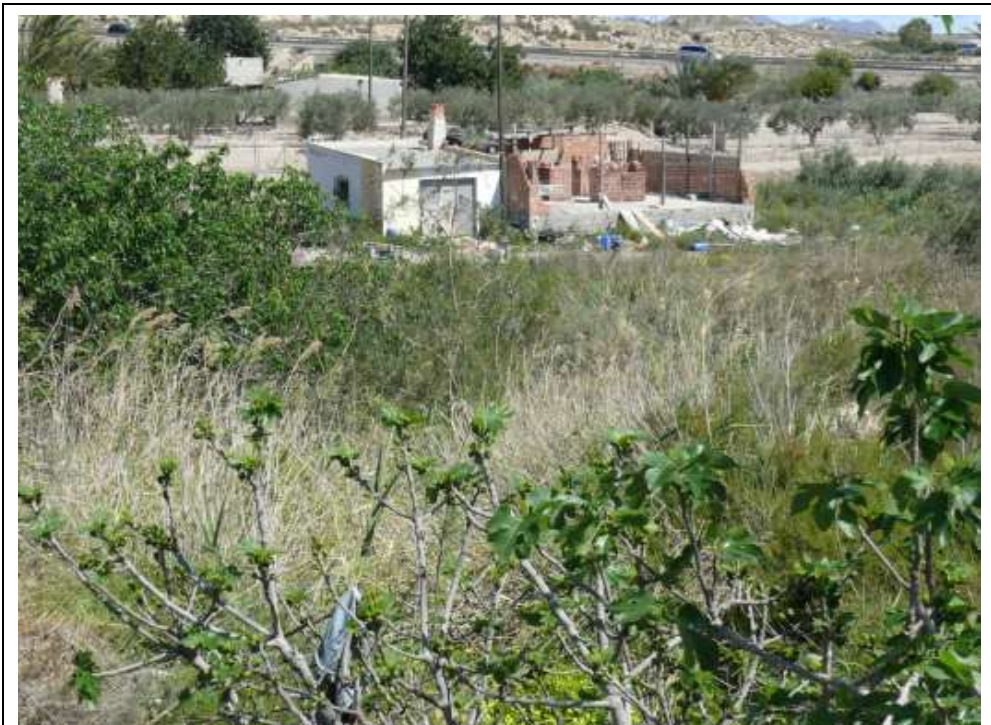
FOTO Nº68: Vista de edificación en margen izquierda del cauce y carretera al fondo
