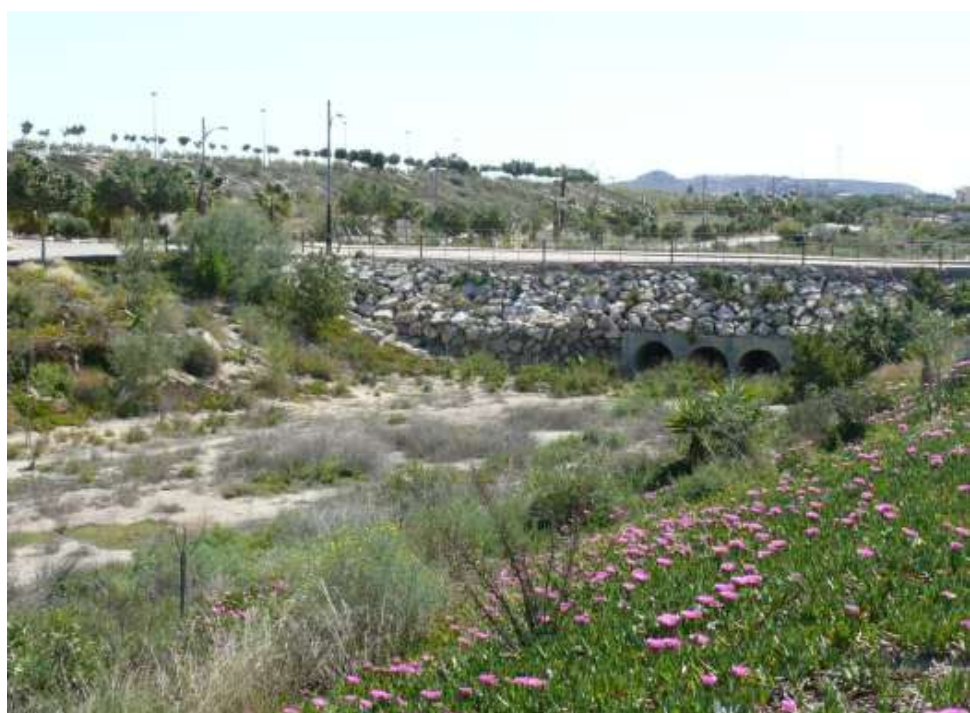
FOTO Nº31: Vista estructura sobre cauce en cruce viario
