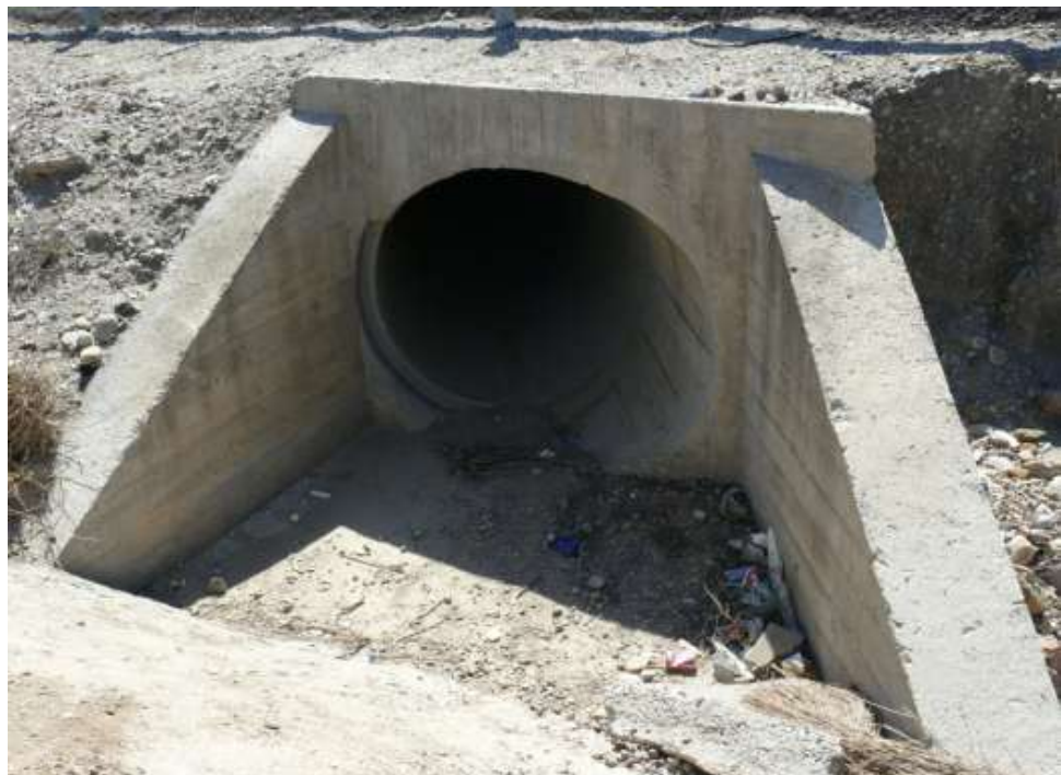
FOTO Nº77: Obra de paso bajo la ALP 116 desde aguas arriba
