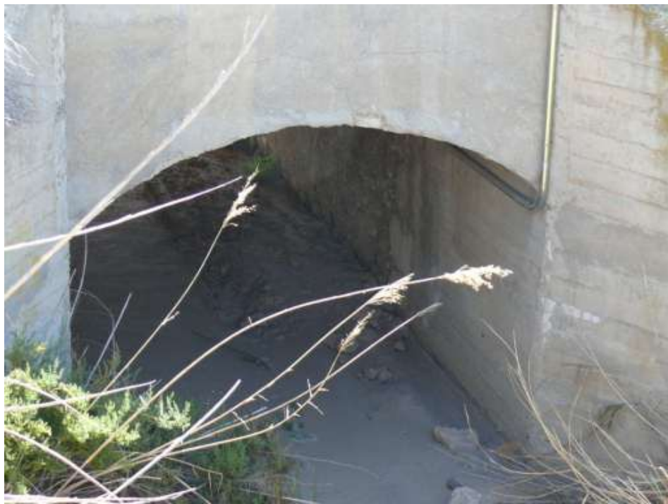
FOTO N°1: Vista de Obra de Paso en Carretera de las cuevas. Marco de Hormigón de 3.00x2.50 m2.
