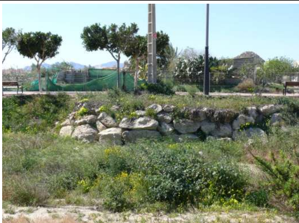
FOTO Nº22: Muros jardinera en escollera, existentes en el cauce
