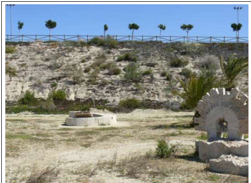
FOTO N°40: Vista de talud de Carretera desde el paseo.
