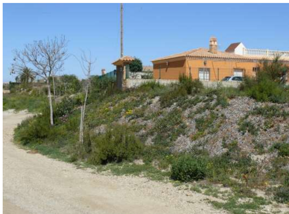
FOTO Nº18: Vista edificación junto talud de cauce en margen izquierdo
