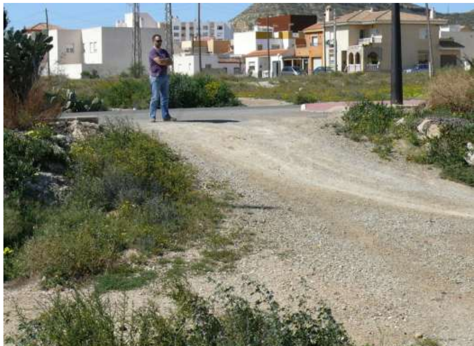
FOTO Nº21: Vista de rampa de acceso al cauce.
