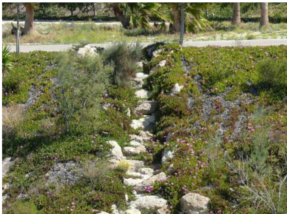
FOTO Nº32: Vista bajante al cauce en escollera
