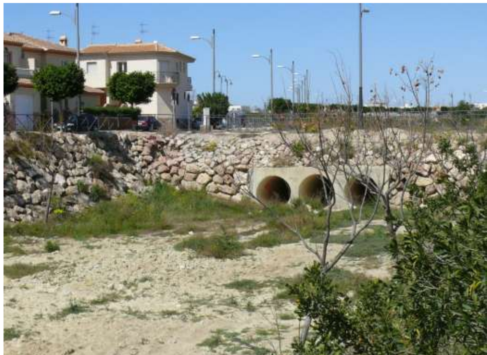
FOTO N°57: Vista de obra de paso hacia aguas arriba
