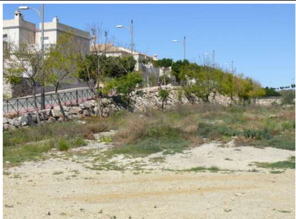
FOTO N°62: Vista de Talud escollera y viario con desnivel hacia aguas abajo. Vial acaba a cota solera del cauce
