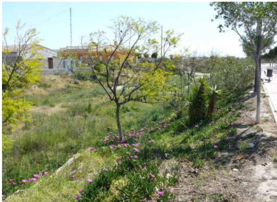
FOTO N°15: Vista cauce en tierras hacia aguas abajo. Sección trapecio de base 15 m y altura 3 m con talud 3/2
