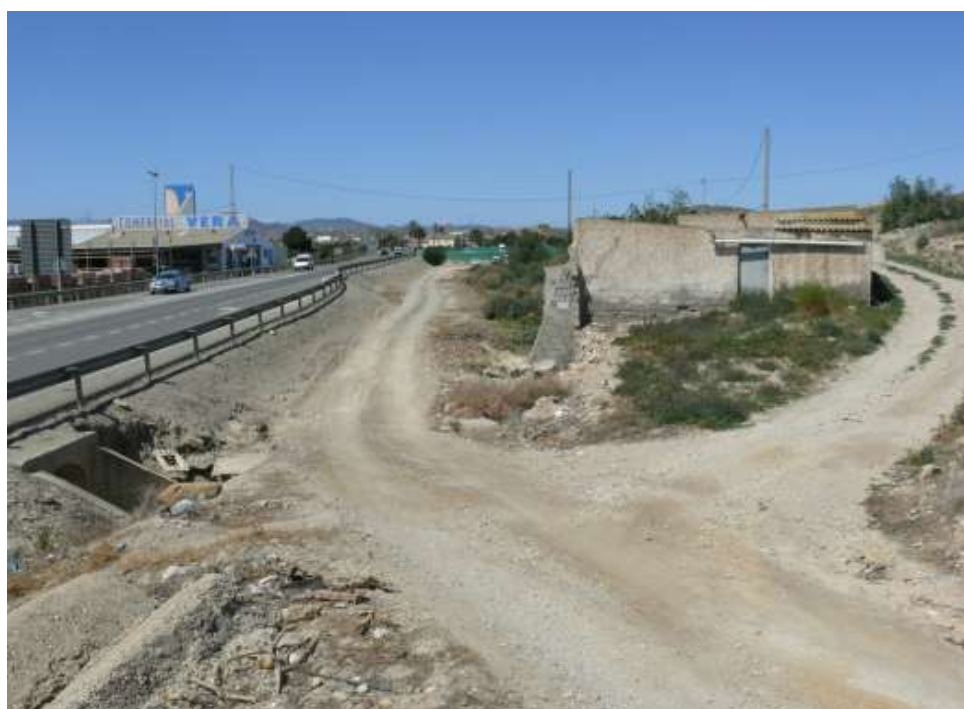
FOTO Nº79: Vista de ALP 116 y vía servicio junto a obra de paso hacia el Oeste
