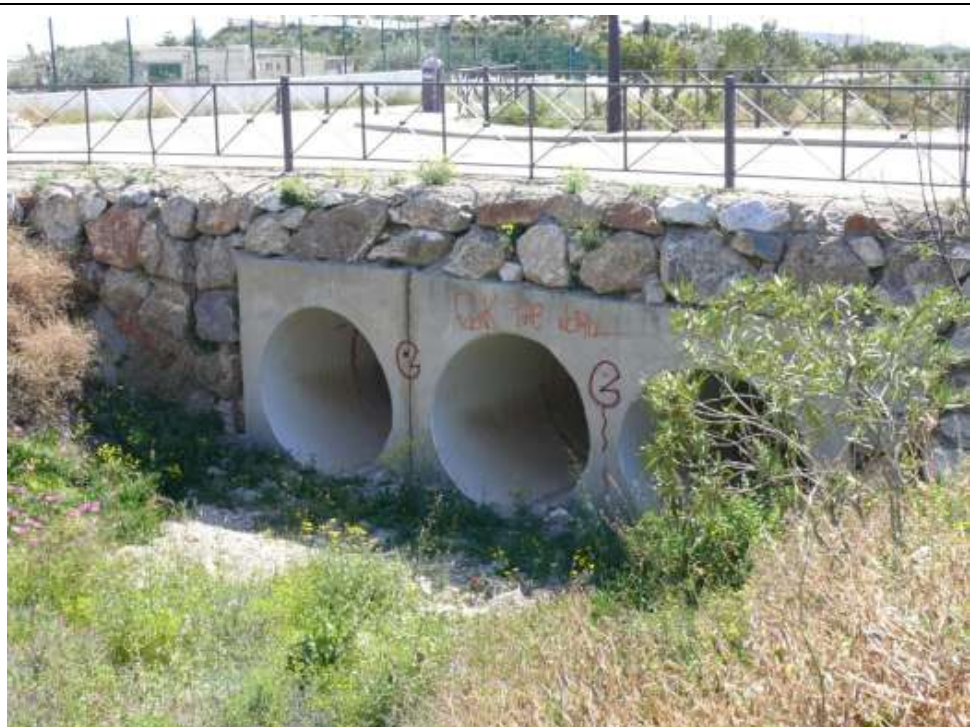
FOTO Nº26: Vista de obra de paso bajo vial sobre el cauce con tres colectores de PVC y 2.000 mm de diámetro.
