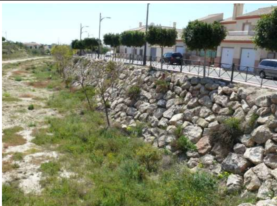
FOTO Nº54: Detalle de talud de escollera en margen derecha hacia aguas abajo
