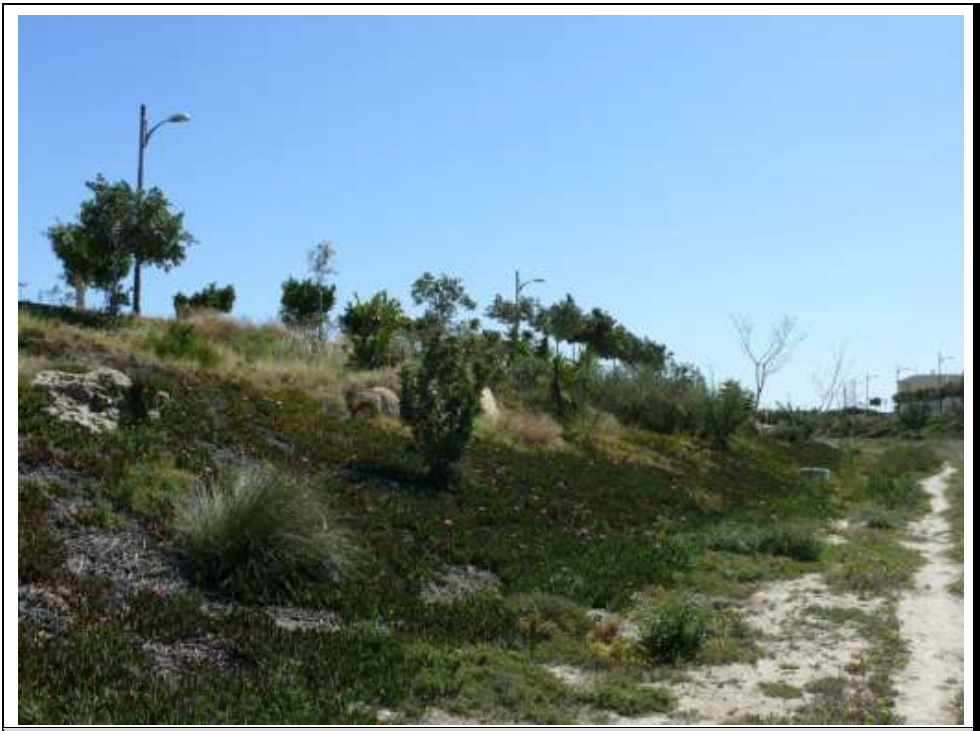
FOTO N°44: Vista desde solera del cauce del talud izquierdo. Cambio de talud y altura de cauce.
