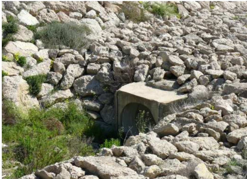
FOTO N°9: Vista de colector en cauce bajo de diámetro 1500 mm
