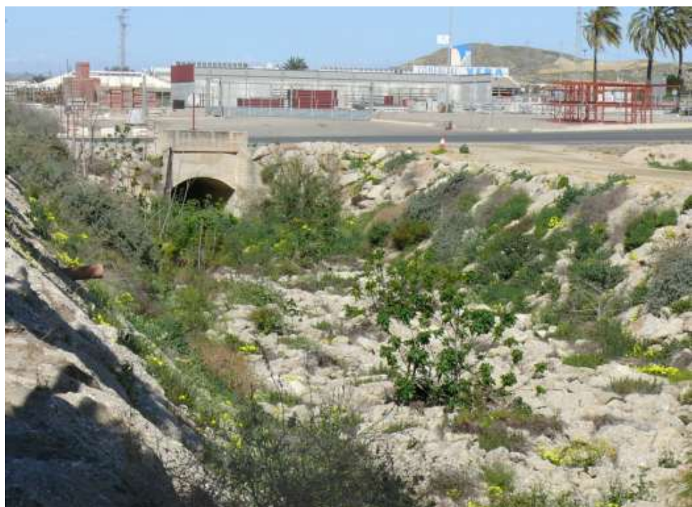
FOTO N°7: Vista de Rambla del Algarrobo aguas debajo de la Ctra. Las Cuevas hacia aguas arriba
